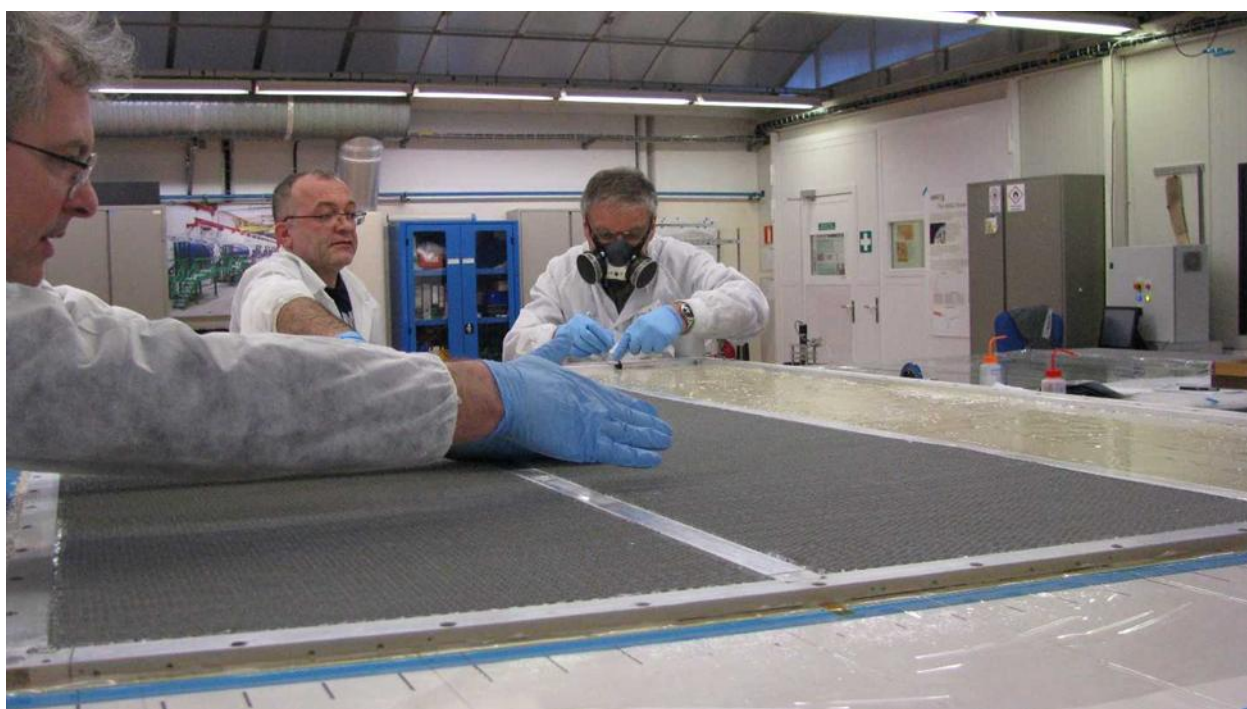
Рисунок 16 - Монтаж сотовых панелей.
