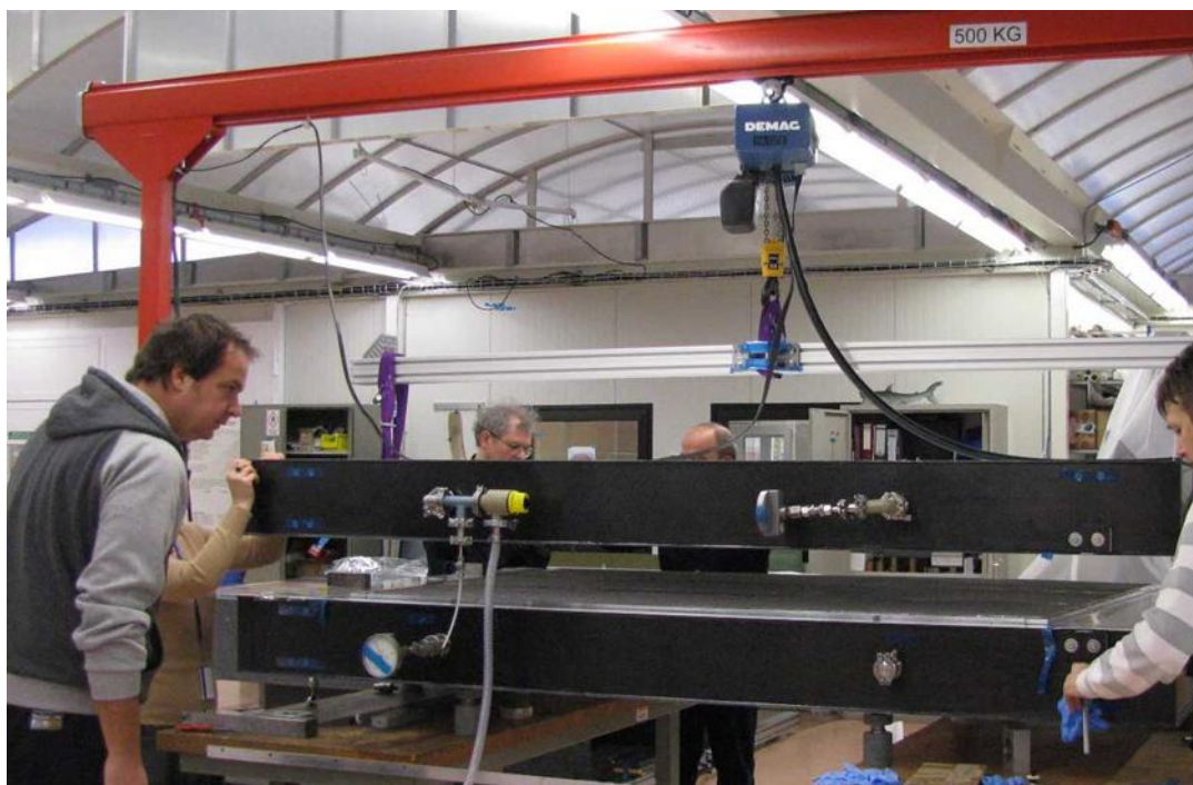
Рисунок 17 - Завершение склейки: МИК между вакуумными столами.
