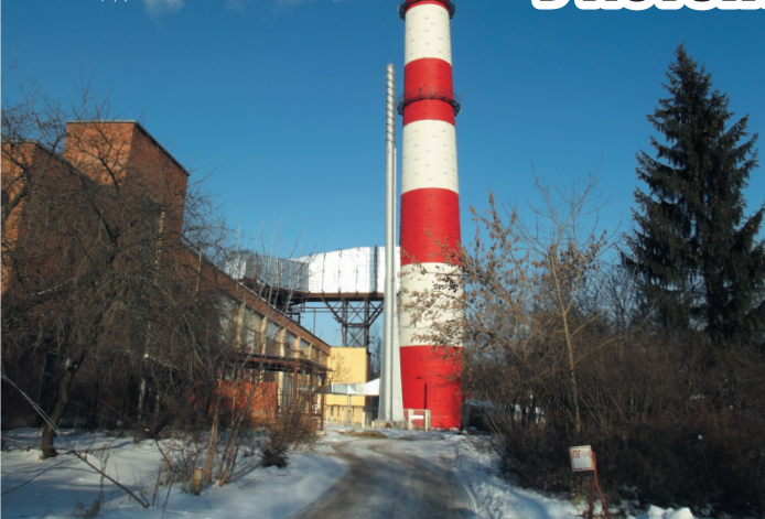
Котельная №1 теплоплощадки У-70
